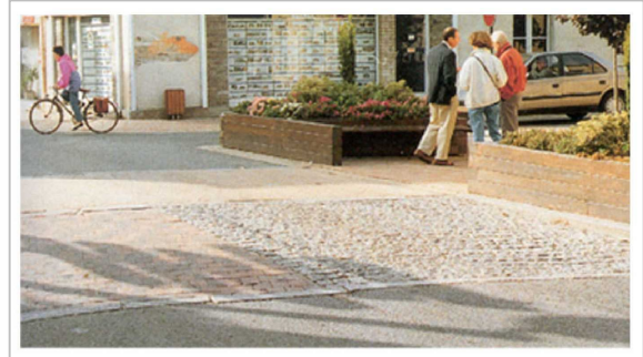
Figura 8.1.20 – Rialzamento della sede stradale in corrispondenza di un incrocio
