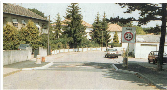
Figura 8.1.16 – Ripartizione funzionale della sezione trasversale di una strada 30
